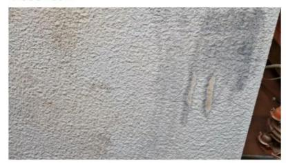
**Rechts;** Mit Derocryl Grip beschichtete Flächen können beschädigungsfrei per HD Reiniger gereinigt werden und können nachbearbeitet werden. **Links:** Die beschichteten Flächen können je nach Verschmutzungsart mit wasserbasiertem alkalischen Reiniger eingesprüht oder gebürstet werden.
